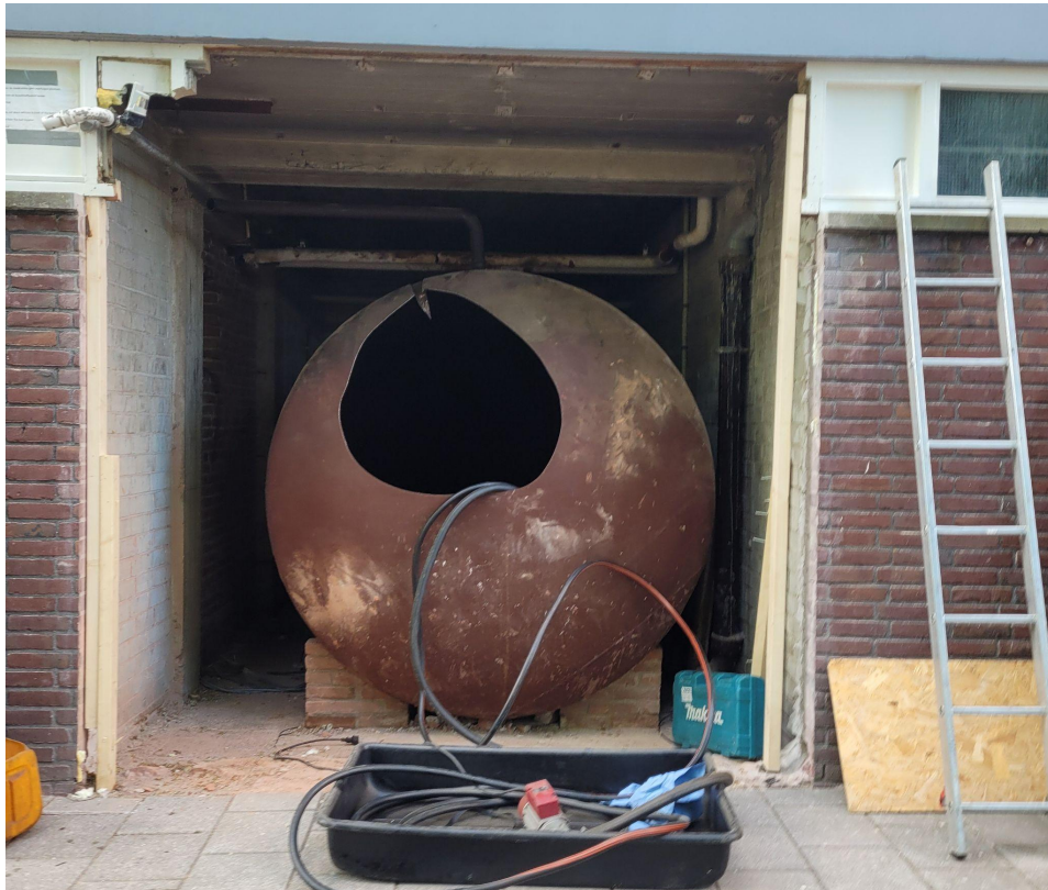
Ontmanteling van oliegestookte blokverwarming voorjaar 2023, Amsterdam
